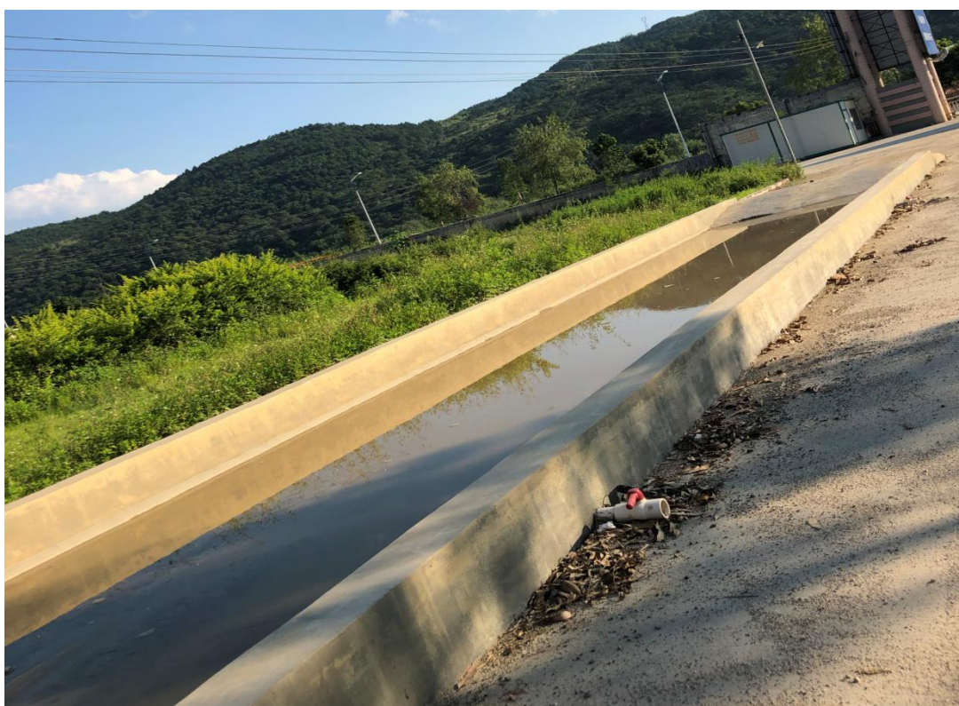
图 3-12 场内出入口洗车槽
