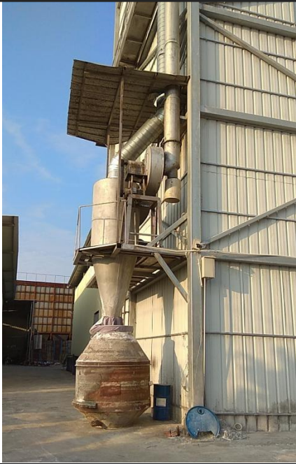
图 3-6 旋风除尘设施及排放筒
