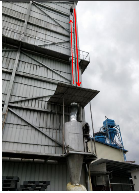
图 3-6 旋风除尘设施及排放筒
